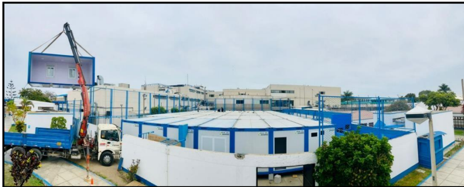
Figura 5.3. Hospital modular en instalación
