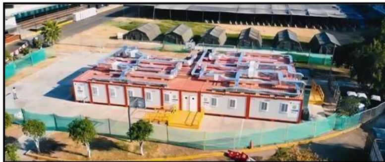
Figura 5.4. Hospital modular instalado
