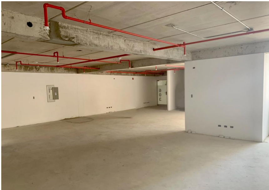
Figura 8. 2. Oficina estándar del edificio Los Inkas
