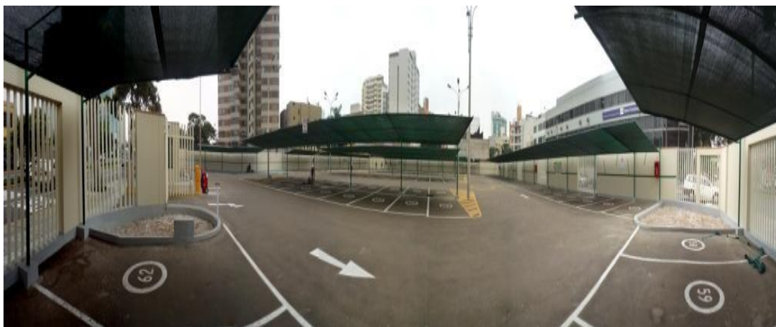
Figura 4.7. Vista interior de la propiedad
