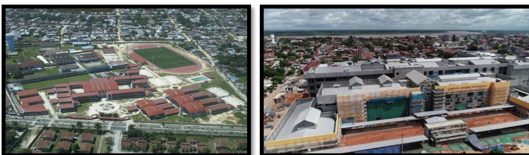
Figura 5.8. Obras de Infraestructura
