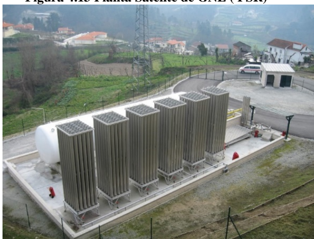
Figura 4.13 Planta Satélite de GNL ( PSR)
